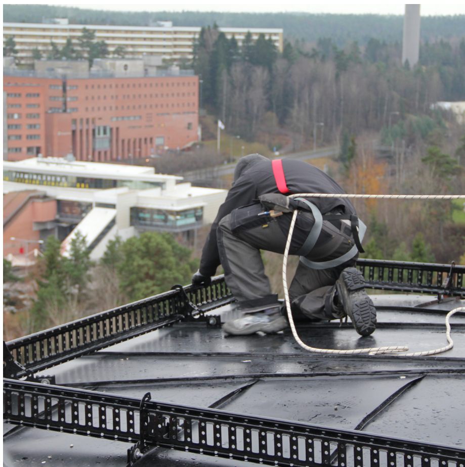
Snörasskydd monteras av plåtslagare (Foto: Pappa Tak, http://pappatak.se/ )
